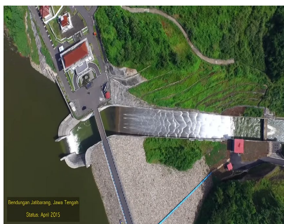
Gambar 2 Tampak Atas Bendungan Jatibarang Sumber : Penulis
